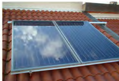
_pannello solare termico
